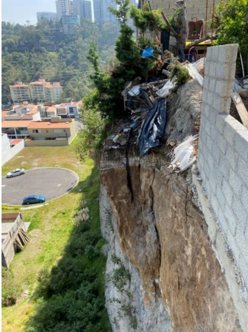
FIGURA 16.- GRIETAS POR PÉRDIDA DE HUMEDAD EN LA PARED DEL CORTE, UBICADO EN EL LÍMITE ENTRE LOS MUNICIPIOS DE NAUCALPAN Y HUIXQUILUCAN, ESTADO DE MÉXICO, SEPTIEMBRE DEL 2020
