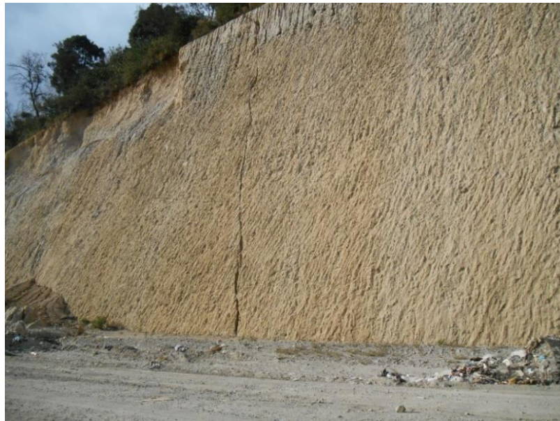
FIGURA 1.- CORTE EN TOBA PARA LA AUTOPISTA TOLUCA – NAUCALPAN, ESTADO DE MÉXICO
